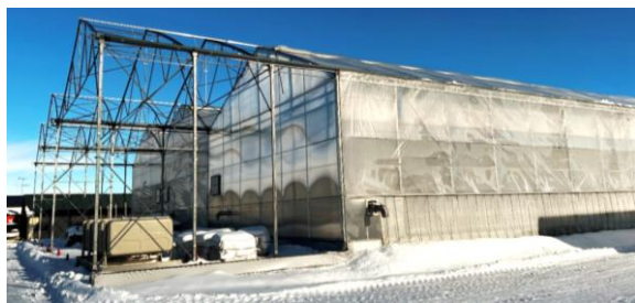
図1. 南西方向からの全体写真
